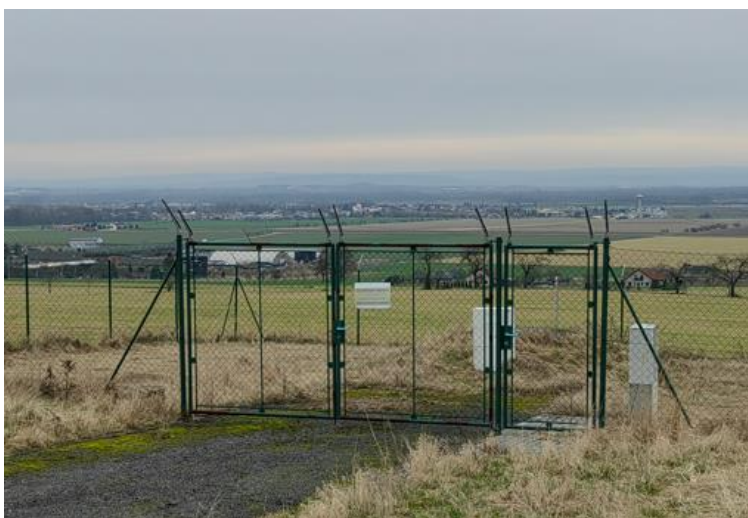
Zabezpečení vrtu – zdroje vody, foto: KHS
