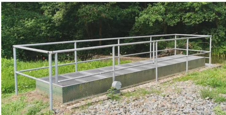
Odběrné místo povrchové vody, foto: KHS
