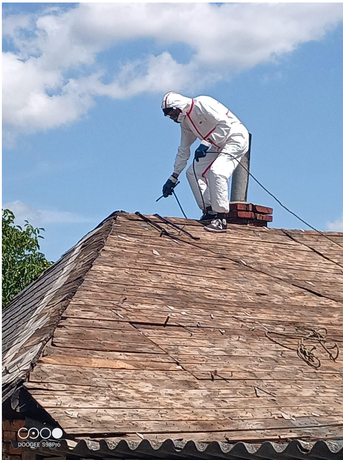
Odstraňování střešní krytiny s azbestem s řádným použitím ochranných prostředků, foto: KHS.
